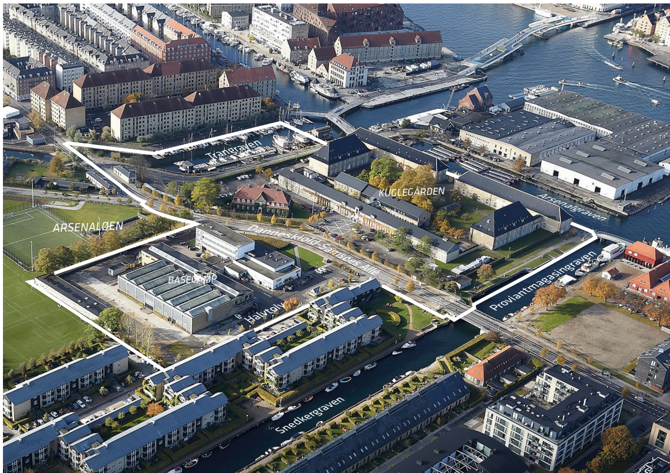
Skråfoto af lokalplantillægsområdet. JW Luftfoto, oktober 2016.
